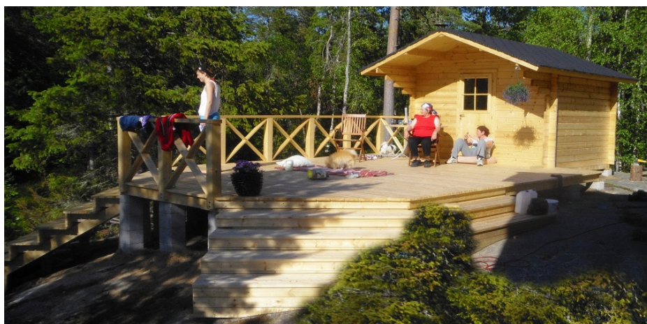
Stockbastu och terrass byggt med EFW virke
